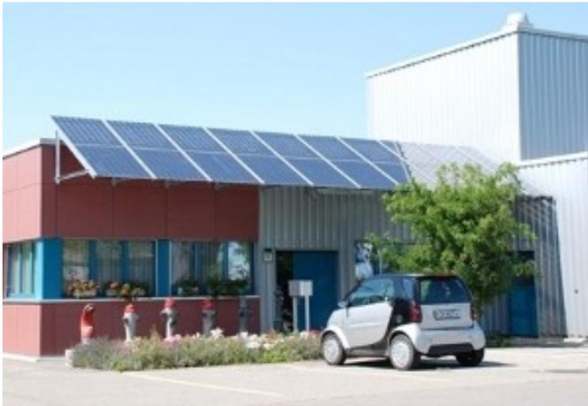
3.4 kW PV-Anlage - Zumikon als transp. Vordach
