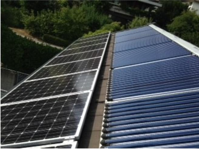
4.5 kW PV-Anlage mit ZRE-Modulen unter bestehende WW-Anlage, Zumikon
