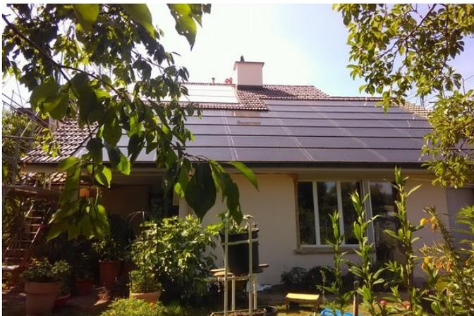
18.9 kW PV-Indach Solrif-Anlage mit Wismar Glas/Glasmodulen auf 2 Dächer, Solaredge Gossau
