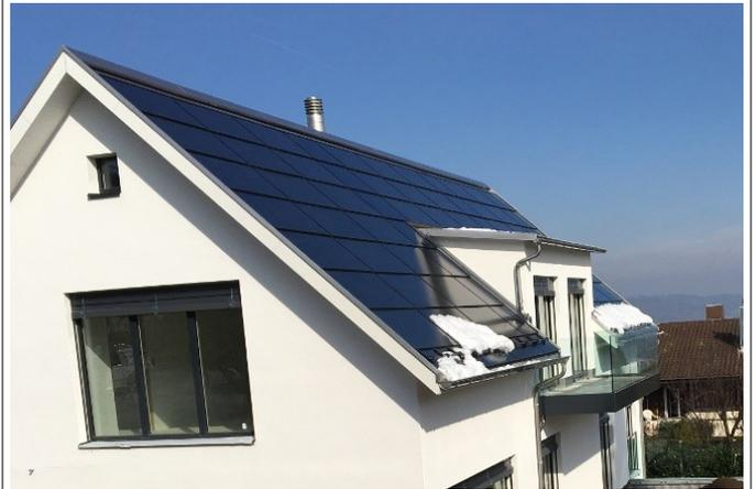
11.7 kW Solrif-Indachanlage mit Sunpower- und Glasblindmodulen in Siebdruck neben Gaube, Bergdietikon
