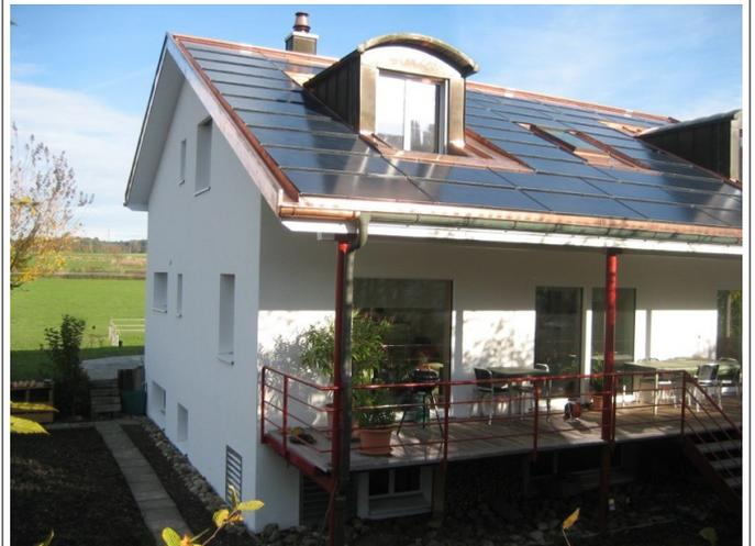
13.6 kW PV-Indachanlage mit Sunpowermodulen und Solif-Indachsystem - Zürich
