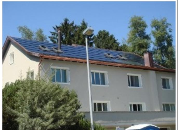
18.2 kW PV-Anlage mit Sunpower-Solrif-System mit Blindmodulen um Fenster und Sonnenkollektoren - Forch
