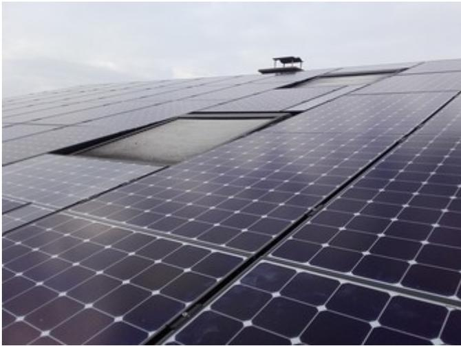
15.75 kW PV-Anlage mit Benq-Modulen – Blindmodule unter und über Fenster, Uetikon am See
