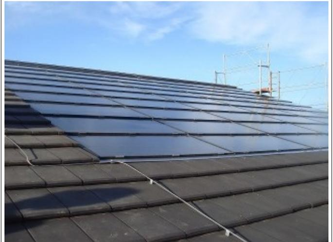
11.23 kW PV-Indachanlage mit ZRE-Modulen und ISMS-Indachsystem - Ebmatingen
