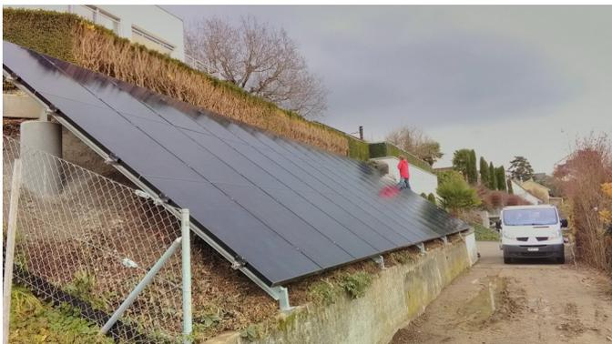
19.65 kW PV-Anlage: 5.25 kW mit Sunpower 345W auf Flachdach und 14.4 kW mit Sunpower black 320 W an Böschung, Herrliberg
