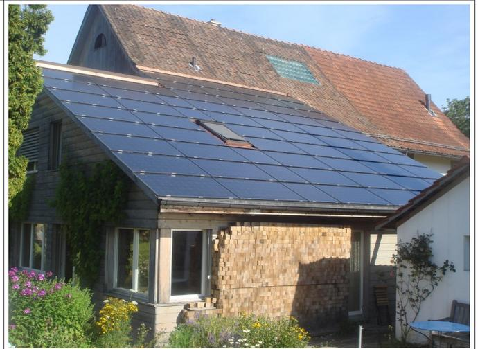
16 kW PV-Indachanlage ZRE/ISMS, aktive Sondermodule in Fensterspalte, Forch
