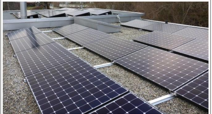
9.7 kW PV-Anlage mit Benq-Modulen (LEC-Round und Alugrid-Montagesystem), Stetten
