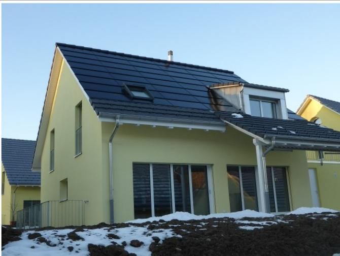
8.5 kW PV-Anlage mit Sunpower/Solrif, inaktive Blindmodule um Fenster und neben Gaube, Lufingen
