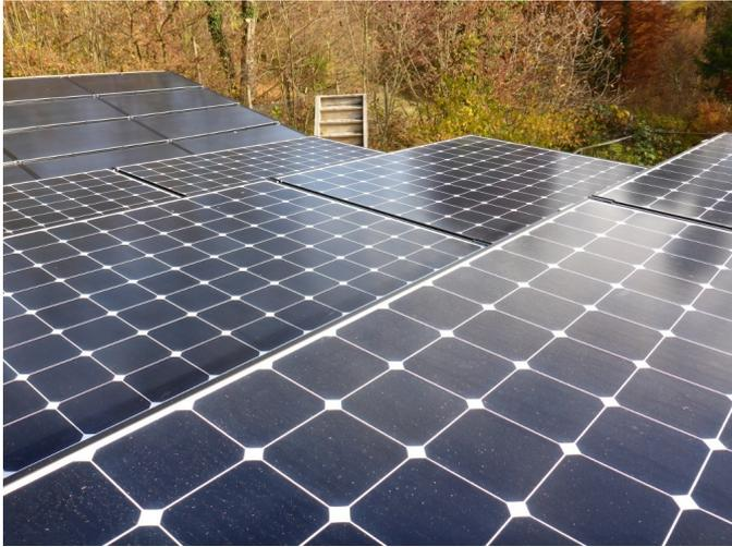
7.5 kW PV-Anlagen (5 kW Indach mit Solrif-Sunpower und 2 kW mit Benq auf Flachdach), Zumikon
