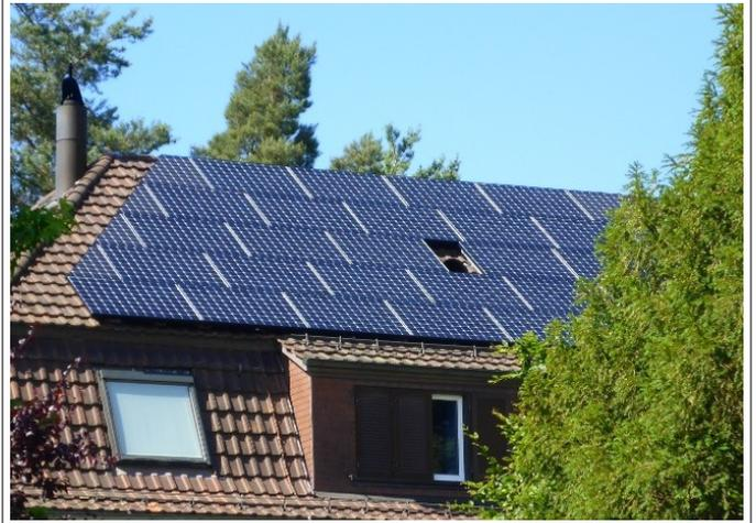
17.3 kW PV-Anlage mit Benq-Modulen, Zürich – Blindmodule über Brandmauer und an den Seiten.
