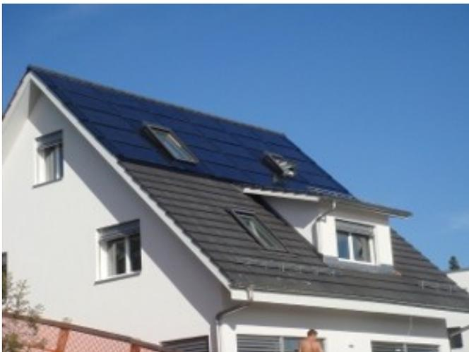
5.6 kW Solrif-Sunpower-Indachanlage: Einfassung der Fenster mit Dummies – Winkel ZH
