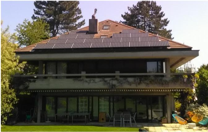
16.75 kW PV-Anlage, 50 Benq-Module 335 Watt auf 3 Dächer verteilt, Solaredge-Optimierer/Module, Zumikon
