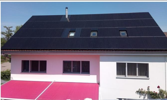
15.6 kW PV-Anlage, Benq-Module 300 Watt, Montagesystem Einlegesystem-Solaredge-Optimier/Modul, Sonder- und Blindmodul, Greifensee
