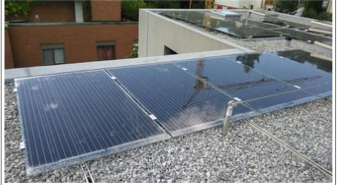
6.2 kW PV-Anlage mit PVP-Glas/Glas-Modulen (Ersatz alter Siemensmodule und Montage auf bestehendes Montagesystem unter Berücksichtigung neuer Absturzsicherung), Zürich
