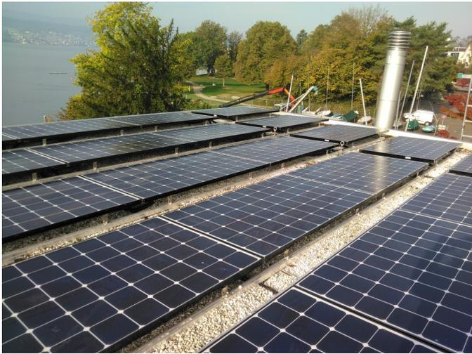
11.26 kW PV-Anlagen, Umbau/Erweiterung einer bestehenden PV-Anlage (4 kW) mit LG-Hochleistungsmodule 365 W (7.3 kW), Meilen
