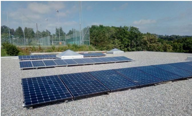
9 kW Ab- und Aufbau einer bestehenden Solaranlage von 1998 (Siemens 55, Siemens 110 und SPR 327W) bei Dachsanierung mit neuem Montagesystem, Küsnacht
