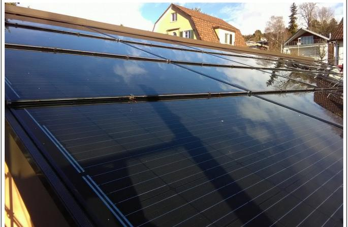
7 kW PV-Indach Solrif-Anlage mit Wismar Glas/Glasmodulen, Solaredge Küsnacht
