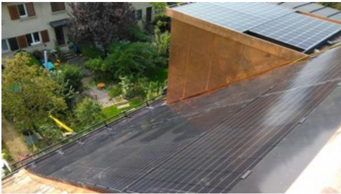
4.4 kW PVT-Indachanlage (Solator) und LG.Module 320 Watt auf Gaube, Zürich
