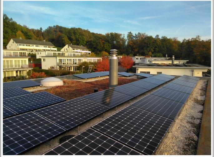
9.4 kW PV-Anlage, Benq-Module 335 Watt, Montagesystem LEC-Quer, Solaredge-Optimier/Modul, Erlenbach
