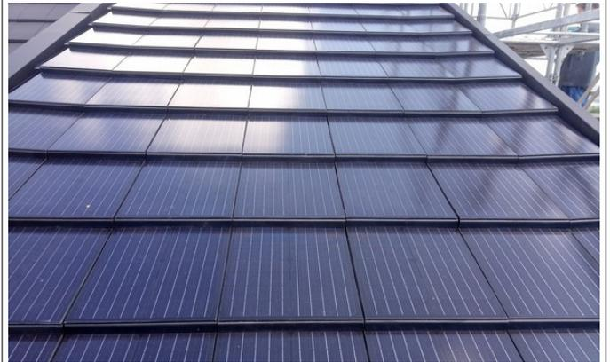
12 kW Cerasolpan-Ziegel von Smartroof Indachsystem – mit Ziegel kompatibel, Bergdietikon
