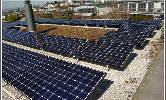
10.05 kW PV-Anlage, Benq-Module 335 Watt, Montagesystem LEC-Quer, Solaredge-Optimier/Modul, Erlenbach
