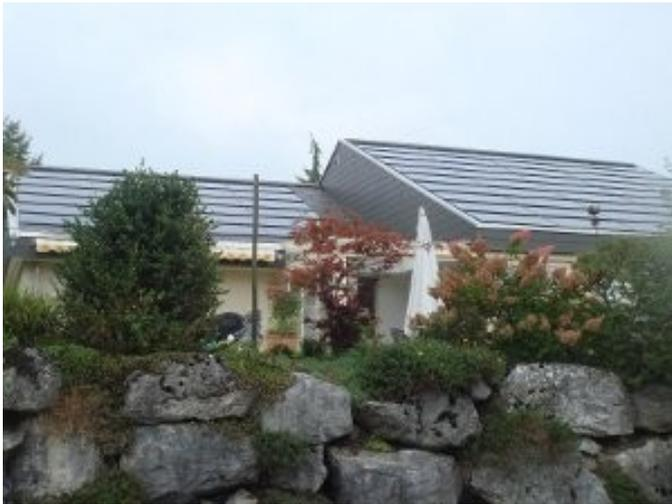
15.3 kW PV-Anlage mit Sunpower und Arres-Indach, Hombrechtikon
