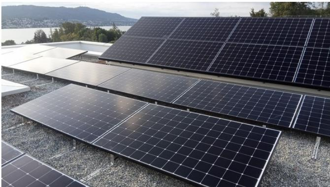
10.7 kW PV-Anlage, Sunpower 360 und 390W Montagesystem LEC-Quer, Solaredge-Optimier/Modul, Küssnacht
