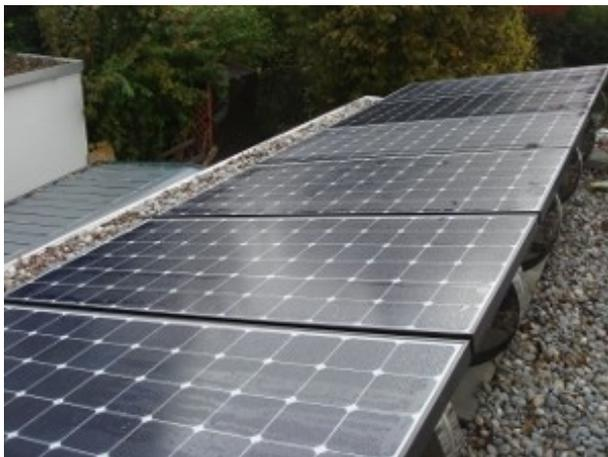
3.8 kW PV-Anlage - Meilen (10 Module auf Schrägdach und 6 Module auf Flachdach mit LEC-Round)
