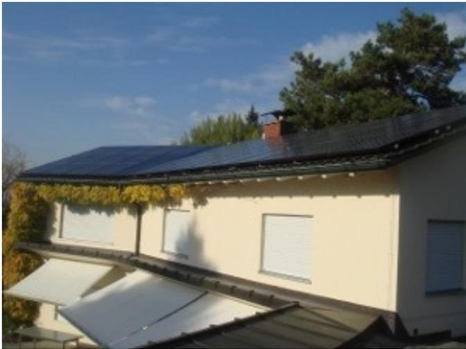
13.44 kW Hybrid-PV-Anlage mit Sonderanfertigung: Auf Sunpowermodule wurden Wärmetauscher angebracht.
