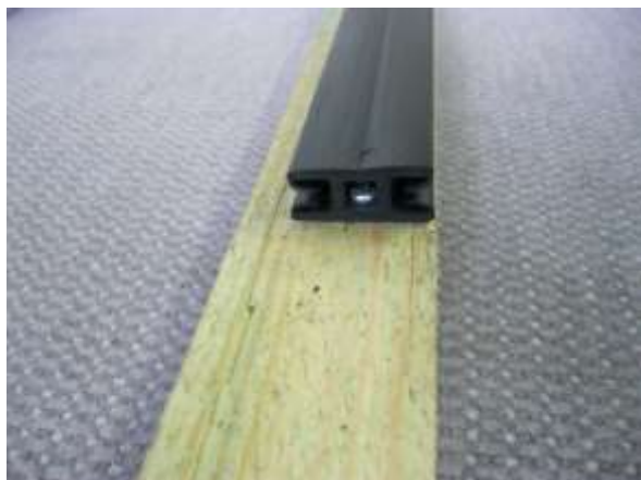
Abb. 8.1.6: Schraubenkopf im Hohlraum des Dichtprofils versenkt
