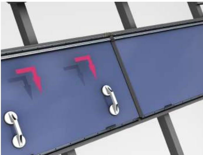
Abb. 8.7.5: Montage des nächsten Moduls
