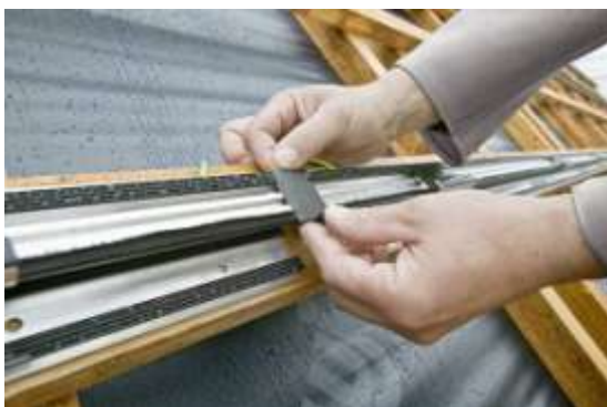
Bild 7: Einsetzen des Kreuzstückes
