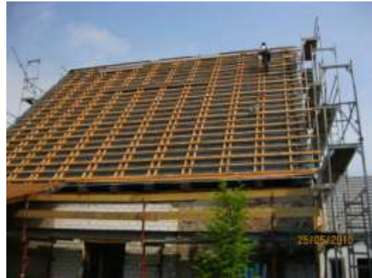
Bild 2: Anbringen der Traglattung
