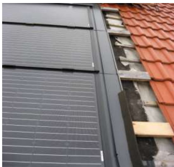
Abb. 8.8.13: Anbringen der Dichtkeile aus Schaumstoff
