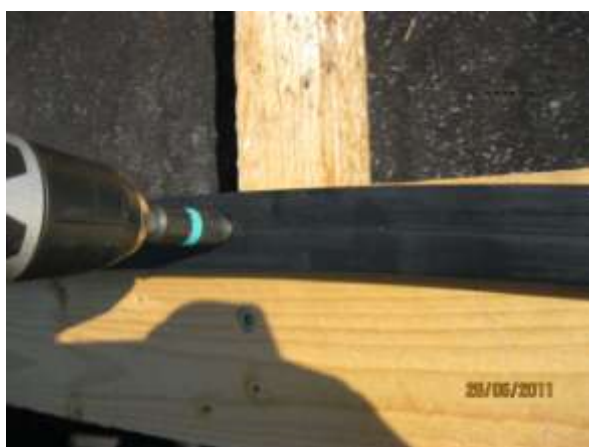
Abb. 8.1.5: Versenken des Schraubenkopfs
