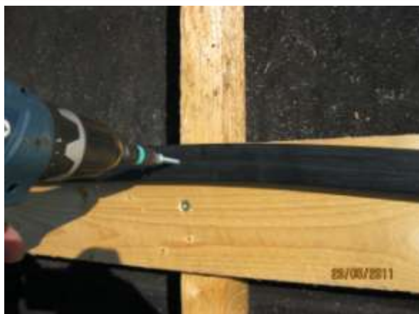
Abb. 8.1.4: Anschrauben des Dichtprofils
