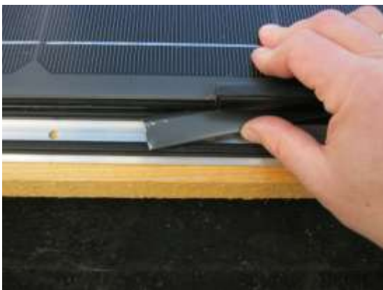
Abb. 8.8.3: Eindrücken der Befestigungsklemme
