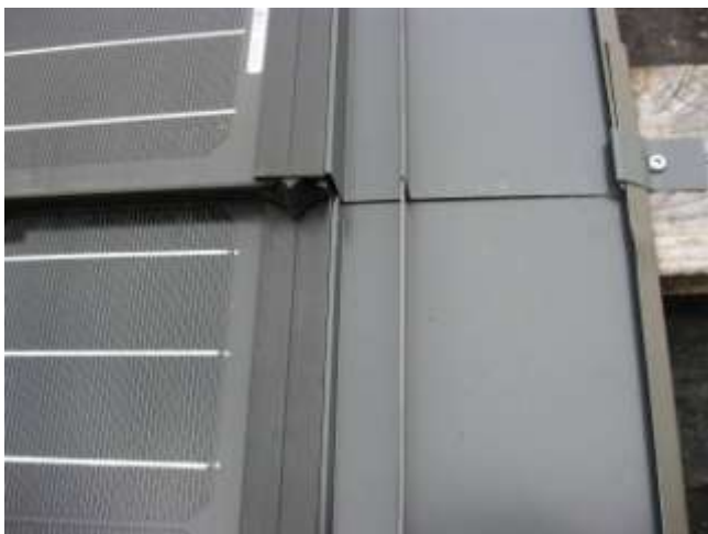
Abb. 8.8.12: Seitlicher Ziegelanschluss
