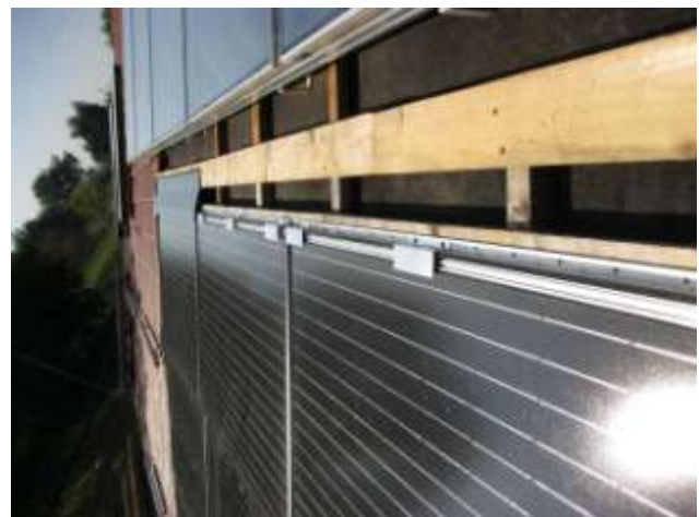
Abb. 8.8.17: Montage der Firsterweiterungsbleche
