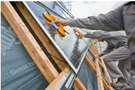
Bild 11: Herunterziehen des Moduls in die Halteklammer
