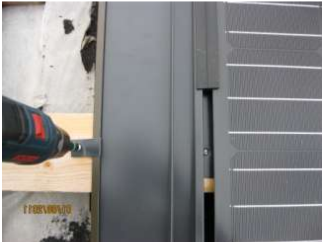
Abb. 8.8.10: Befestigung des Seitenblechs
