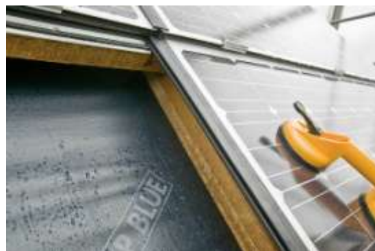
Bild 8: Einsetzen des Dichtprofils
