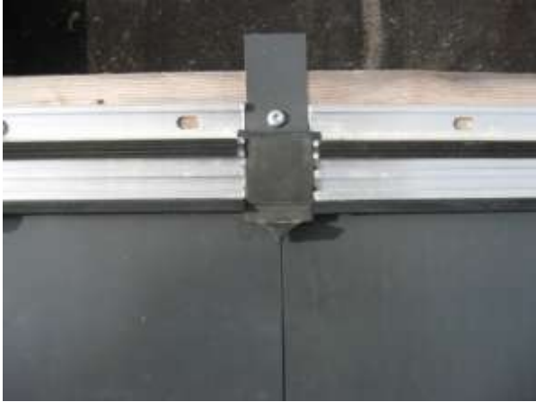
Abb. 8.8.7: Einsetzen des Kreuzstückes
