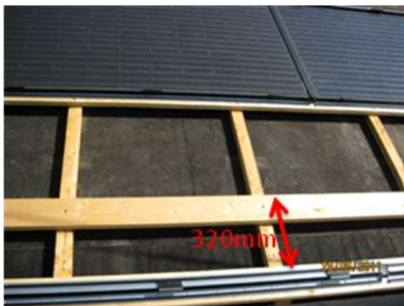
Abb. 8.1.3: Zusätzliche Traglatte/Hilfslatte
