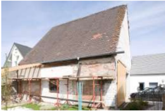
Bild 1: Dach vor der Montage
