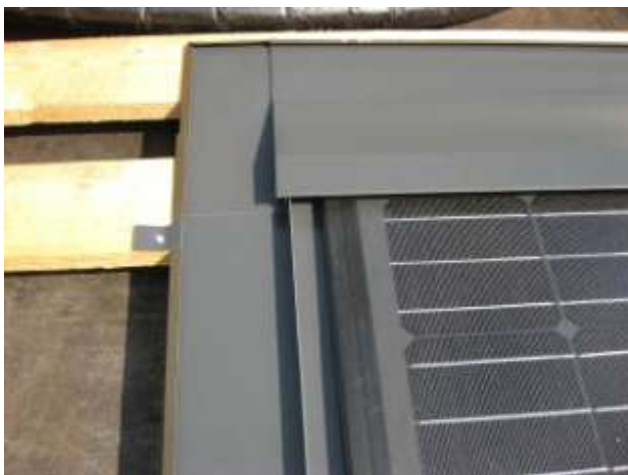
Abb. 8.8.16: Montage des Firstblechs mit Ecke links
