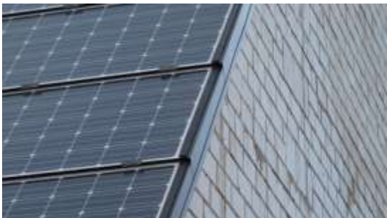
Bild 13: Abschluss Ortgang
