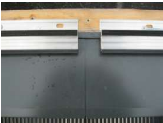
Abb. 8.8.5: Eingeschobenenes Traufblech
