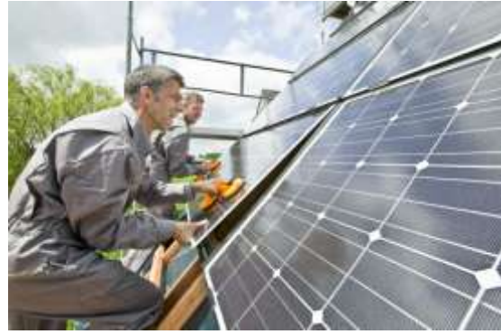
Bild 10: Einschieben des Moduls oben
