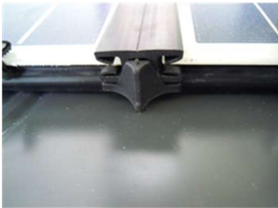
Bild 8.8.8: a.) richtig: Kreuzstücknase liegt auf
