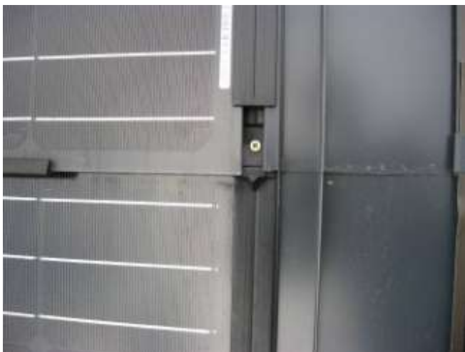
Abb. 8.8.11: Fixieren des seitlichen Kreuzstückes mit Schraube
