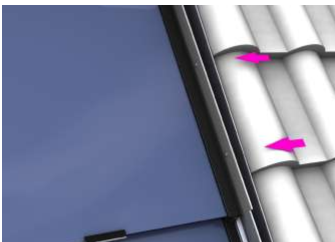
Abb. 8.8.21: Vernietung der seitlichen Übergangsbleche mit Ziegelanschlussblech
