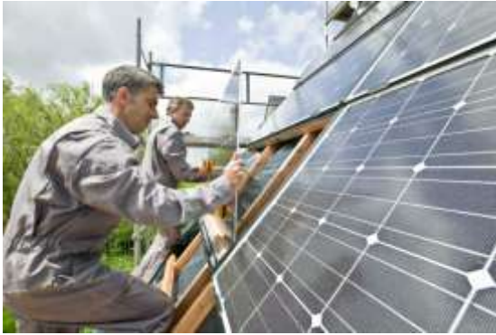
Bild 9: Abstellen des Moduls für den Elektroanschluss
