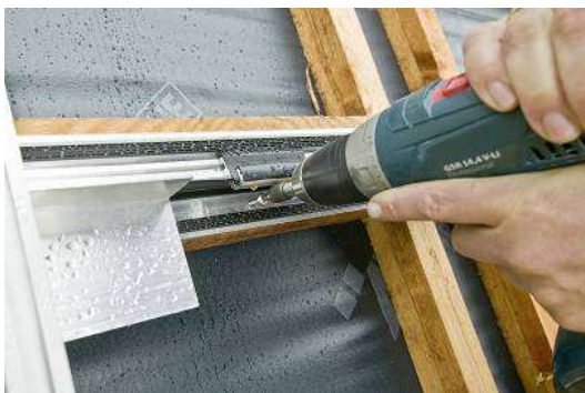
Bild 5: Anschrauben der Halteprofile
