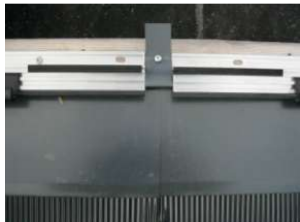
Abb. 8.8.6: Befestigungswinkel zwischen 2 Halteprofilen
