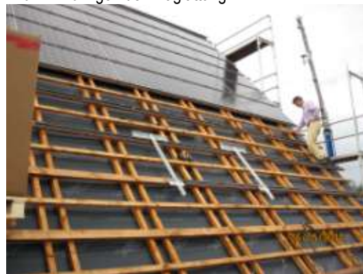
Bild 4: Montage der Halteprofile mit Montagelehren
