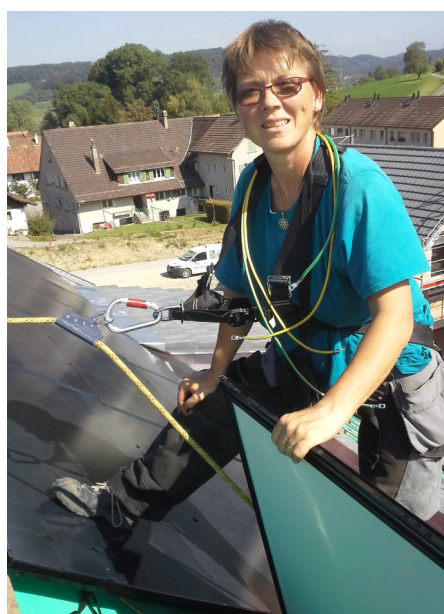
2 Eva Leutenegger montiert, gut gesichert, PV-Paneele auf einem Dach.
